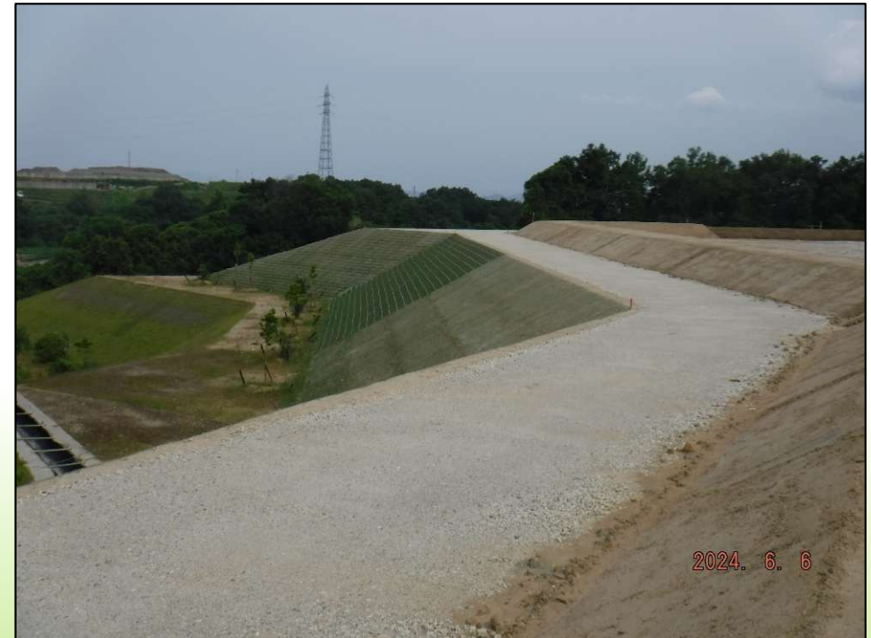
法面の様子②
