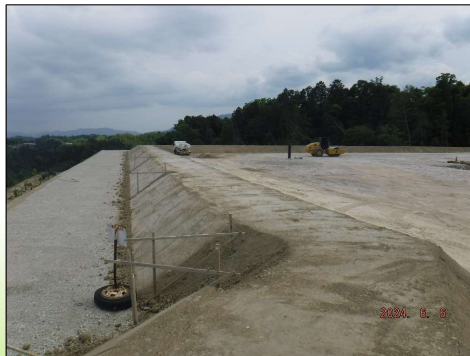
土堰堤（高さ1mの小段）の施工状況
